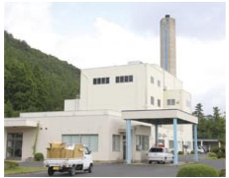
島後清掃センター（岬町）：町内で発生する可燃ごみ処理施設として平成5年に開場しました。整備後18年が経過し、平成21年度までに約10万t以上のごみを焼却してきました。処理能力も限界が近付いており、施設の延命化が必要となっています。
